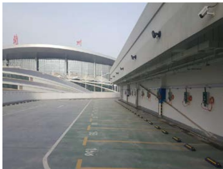
兰州机场停车楼
